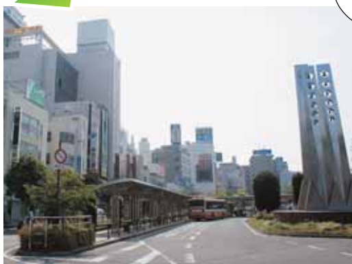
平成7年に完成した駅前広場（平成25年撮影）
