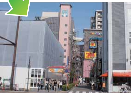
現在、駅前再開発仮設店舗棟を建設中。
