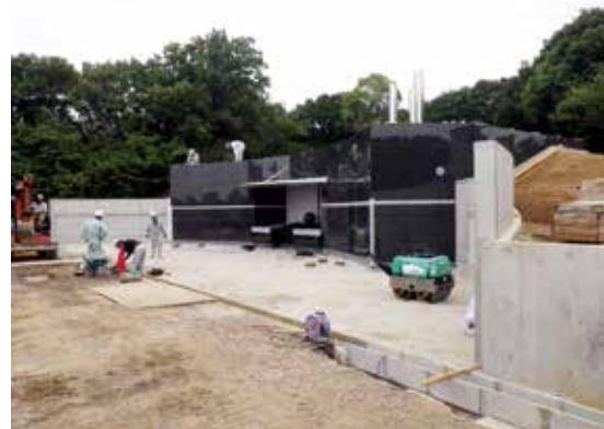
工事が進む合葬式墓地（6月26日撮影）
