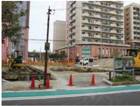
工事が始まった送迎保育ステーション
